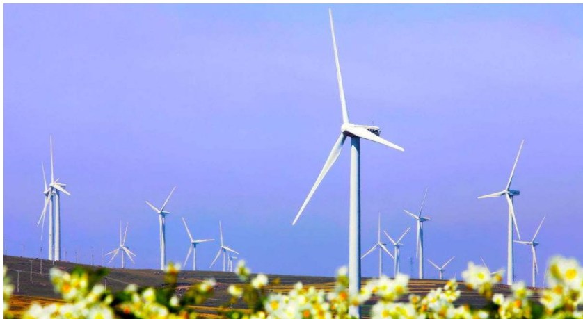
沈阳风力发电项目 Wind power project in Shenyang
