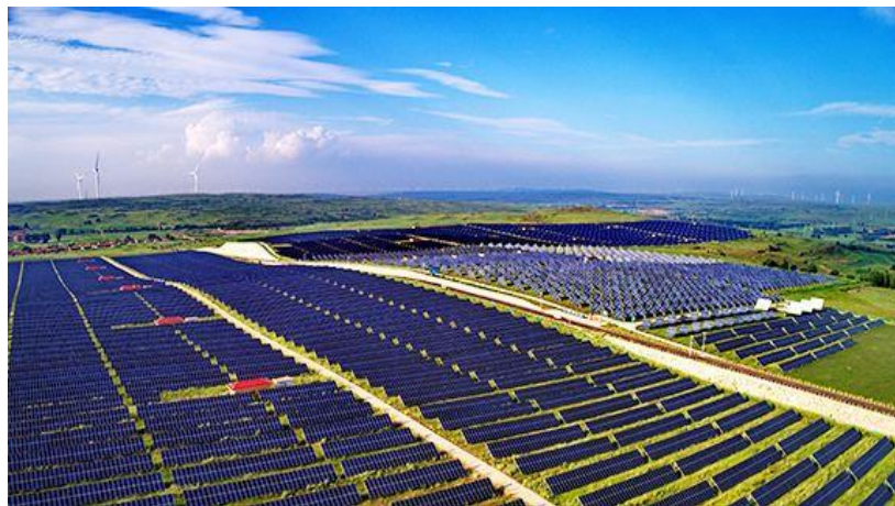
沈阳光伏发电项目 Photovoltaic power project in Shenyang
